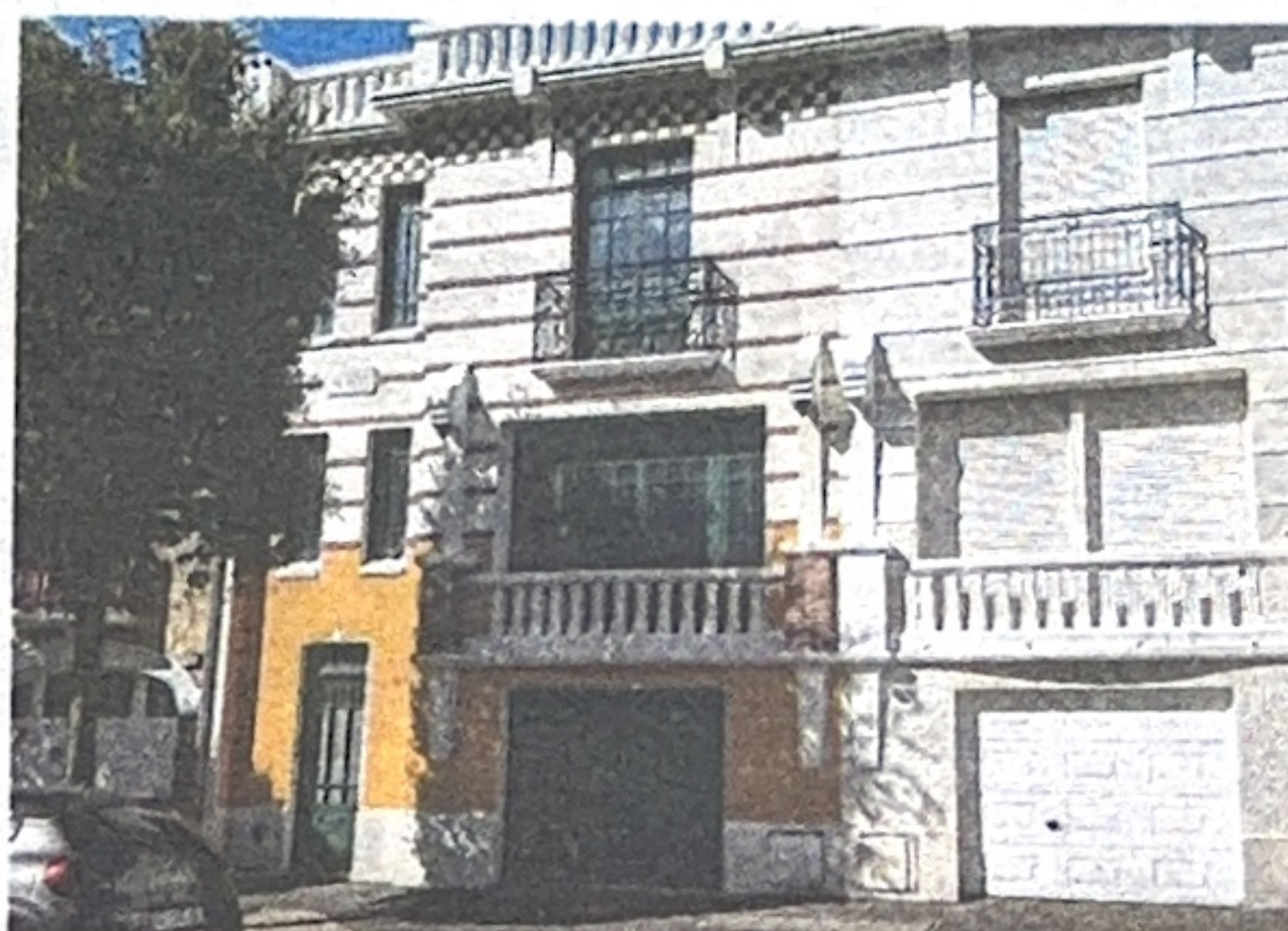
Cette villa de l'avenue Paul-Doumer, récemment rénovée, a reçu le prix du patrimoine pour l'excellence de sa restauration. Les couleurs sont ici utilisées à la fois sur la façade mais aussi à travers les huisseries et les briquettes.
